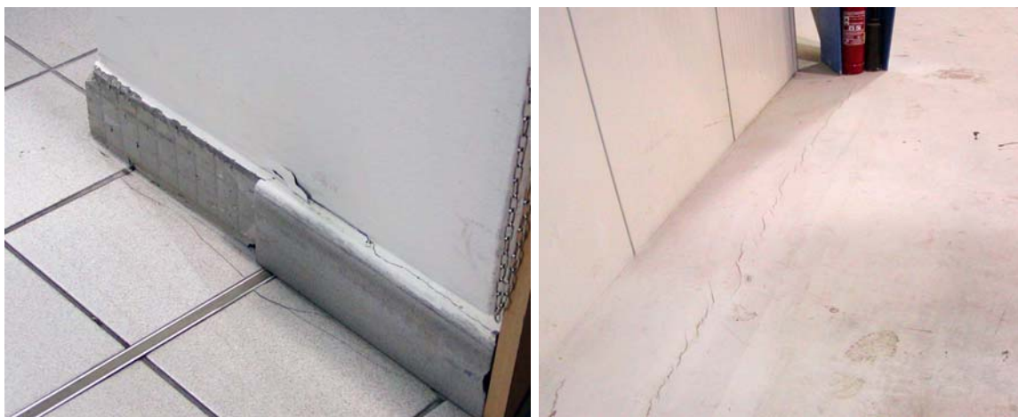
Obr.3 Trhliny okolo sloupů a) obchodní hala, b) skladová hala
