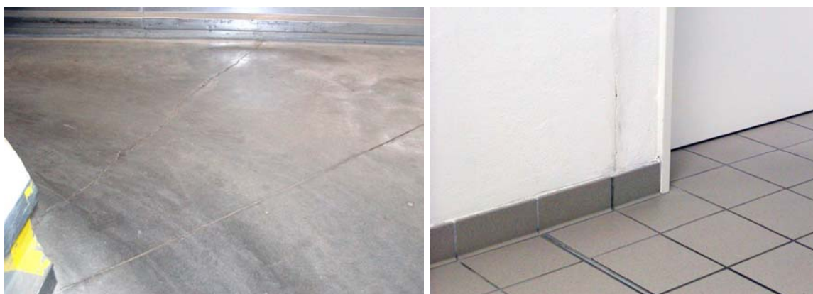
Obr.4. Trhliny v těsné blízkosti dilatačních spár a) trhlina vedle dilatační spáry v podlaze skladu b) pokračování trhliny z dlažby vedle dilatační spáry ve stěně
