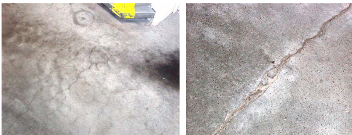
Obr.5 Trhliny v podlaze skladu a) počáteční mapové b) po vytlučení od přejezdu vozíků
