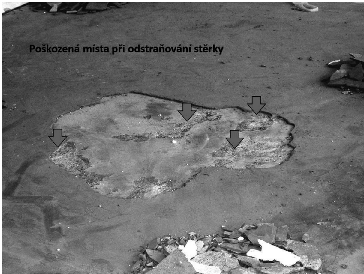
Obr.5 Poškozená místa v anhydritové vrstvě při odstraňování stěrky
