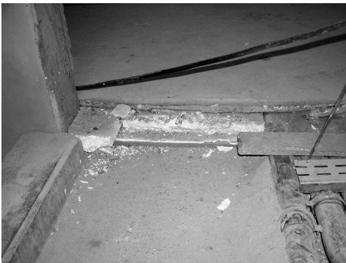
Obr.2 Rozvody v podlaze na úrovni polystyrénové vrstvy
