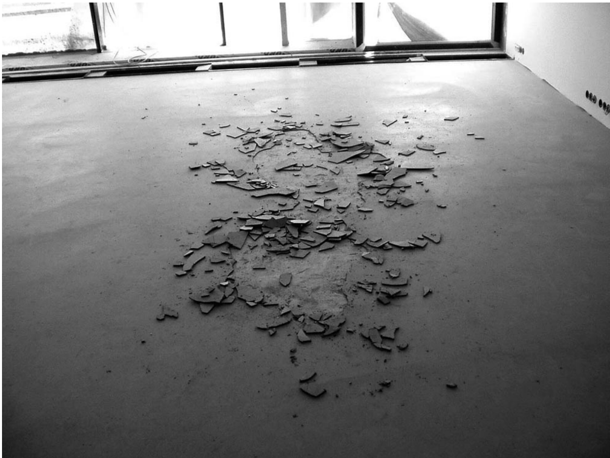
Obr.3 Poškozená vyrovnávací vrstva stěrky
